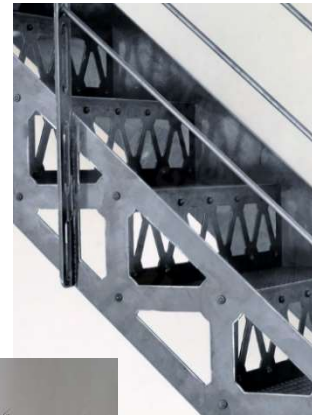
Escalier LA BAULE
